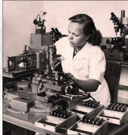
Eine der ersten Institutsaufgaben: die Kalibrierung von Härteprüfplatten.
