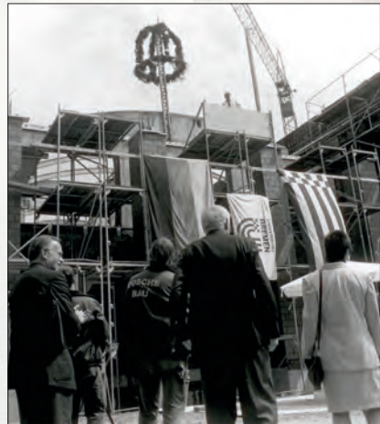
Richtfest des neuen Laborgebäudes an der Universität Bremen im Jahre 1989.
